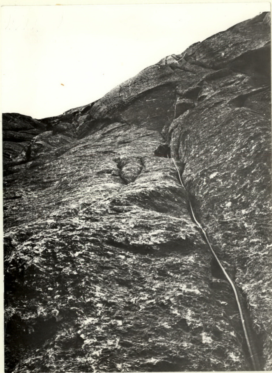
Фото 3. Внутренний угол с карнизом (участок 3-4)
